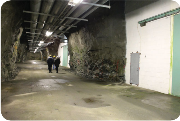
DEPONIET INNE I FJELLET BESTÅR AV LUKKEDE «ROM» MED BETONGSARKOFAGER TIL OPPBEVARING AV DET RADIOAKTIVE AVFALLET.
