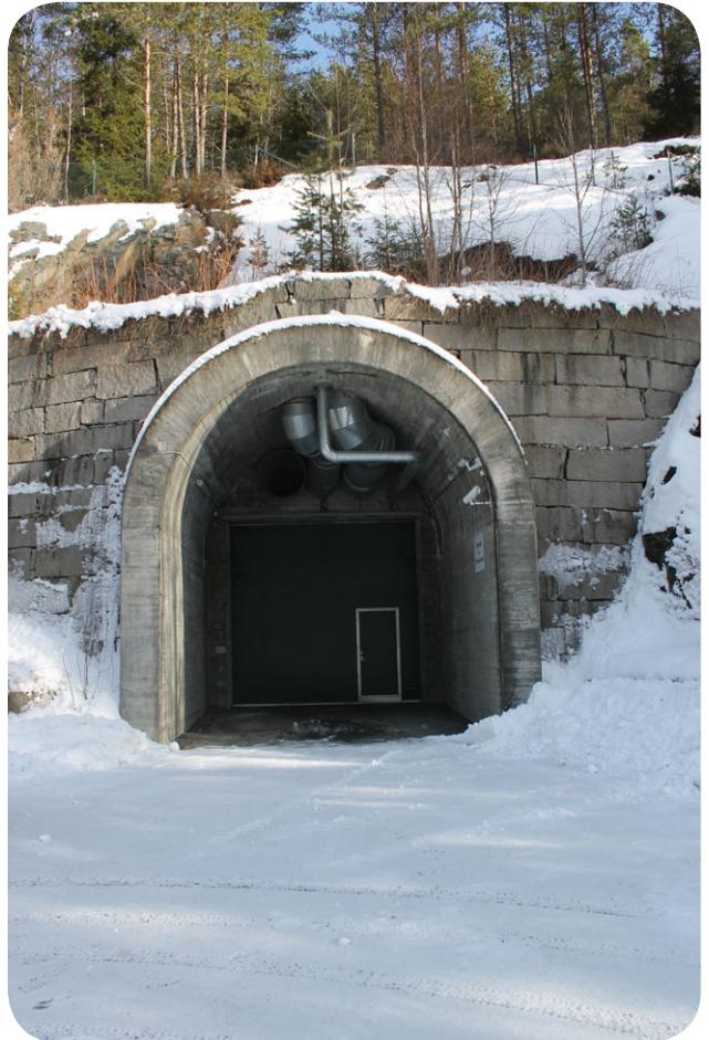
Inngangen til deponiet i Himdalen i Østfold.
